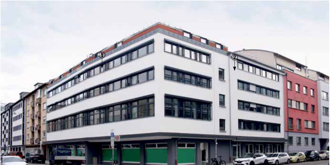
Das sanierte Gebäude in der Silberburgstraße. Links (1) im ersten Stock der Sitz der Geschäftsstelle, rechts das „kleine Haus“ (2), das der Verein vermietet.
